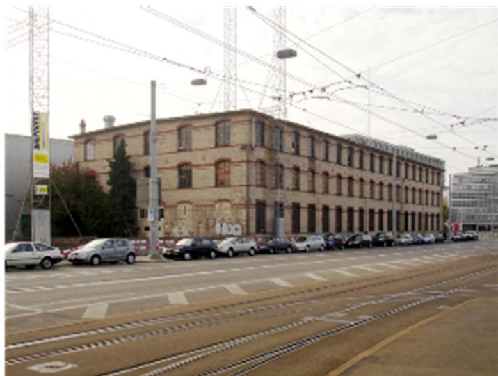
Referenz 3 : Escher-Terrassen, Hardturmstrasse 5, 1900, Sanierung im Gang
