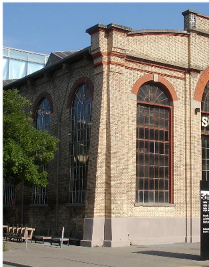
Referenz 4: Schiffbau - Zürich West ende 19. Jahrhundert, saniert 2000
