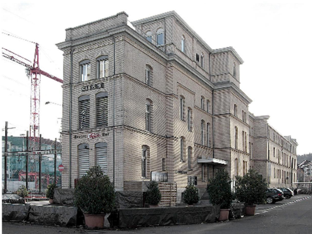
Referenz 2 : Gleis 9 - Zürich Oerlikon, 1889, saniert und verschoben 2012
