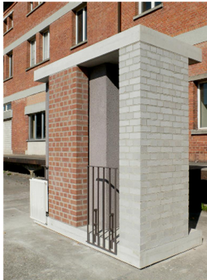
Mauerwerk der bestehenden Hallen, Hofmauerwerk, Ansicht vom Mockup, 2011
