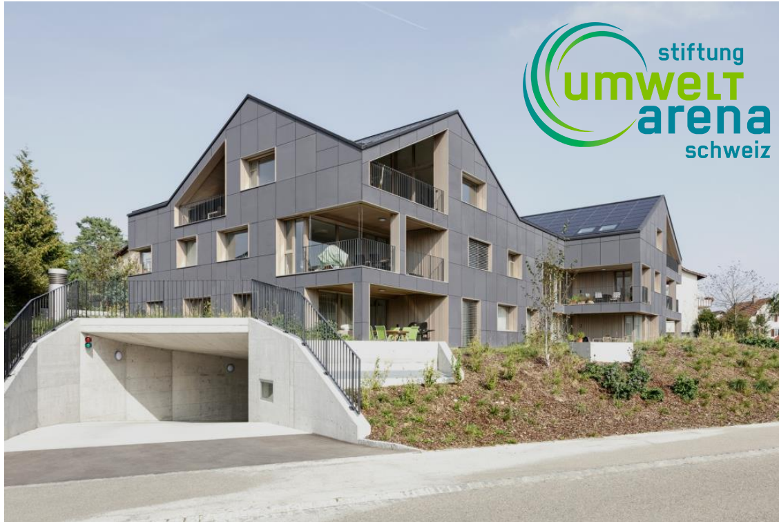
Energieautarkes Mehrfamilienhaus in Brütten, 2015, Saisonale Stromspeicherung mit H 2
