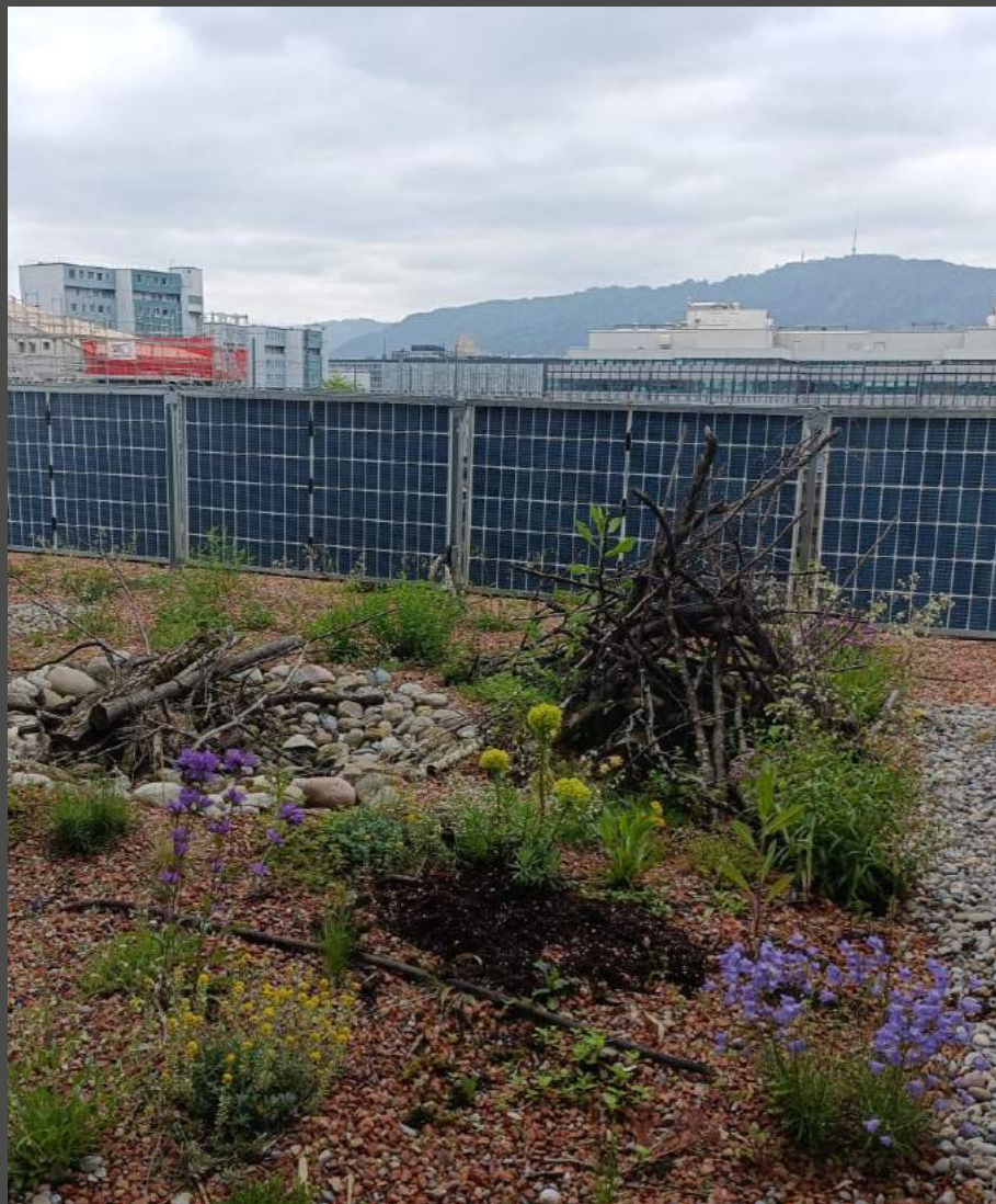
Senkrechte, bifaziale Solaranlage, ZKB
