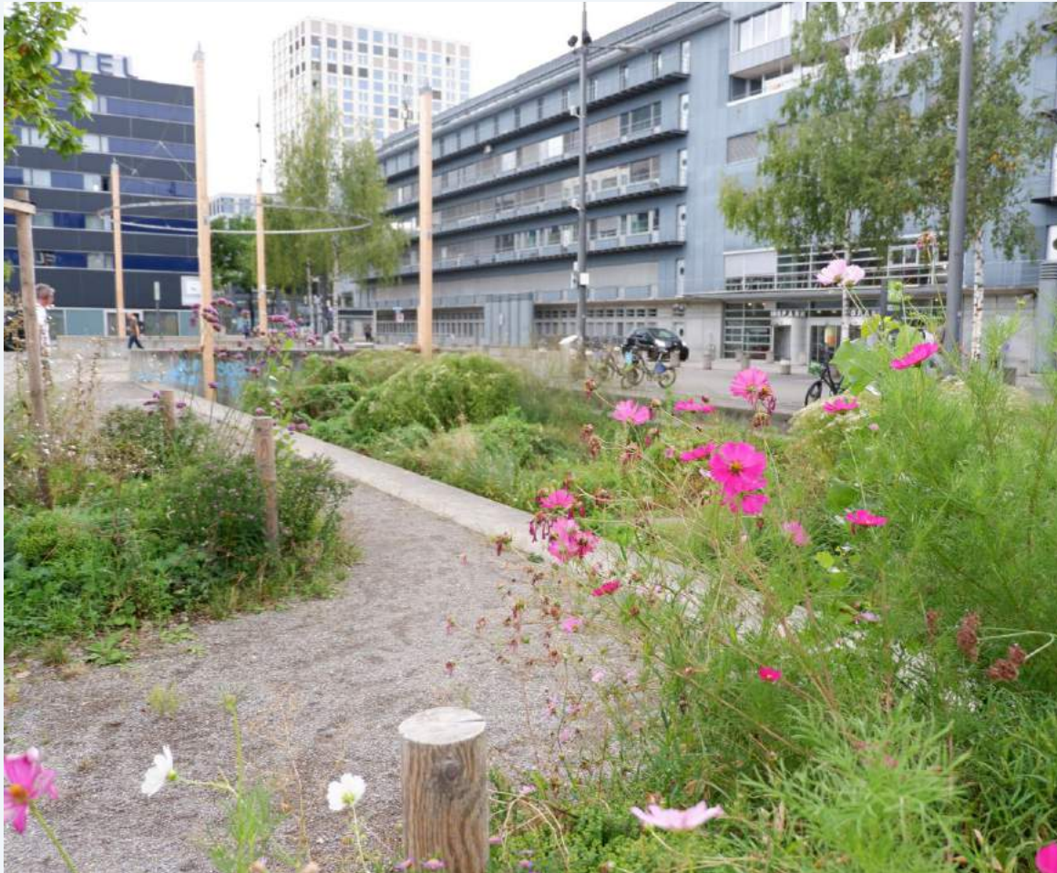
Versickerungsmulde Turbinenplatz, Zürich
