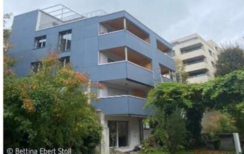
Das auf einer hinterliegenden Parzelle im Zürcher Kreis Fluntern gelegene Mehrfamilienhaus ist im Minergie-P-Standard in Holzbauweise mit Photovoltaikfassaden, PVT-Kollektoren auf dem Dach und Regenwassertank ausgeführt.
