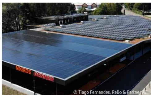
Die Migros Zürich betreibt in Schlieren seit dem Jahr 2019 ihre vierte Plusenergie-Filiale. Mehr als 100 % des verbrauchten Stroms wird via Photovoltaik-Anlage auf dem Dach erzeugt. Im Jahr 2021 wurde zudem ein Salz-Nickel-Batteriespeicher in Betrieb genommen, um die Überschussenergie des Tages in die Nacht zu verschieben.
